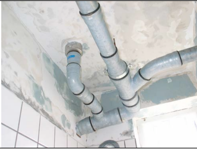
Afdeling K, stuen til venstre Venstre baderum Venstre side, facade
