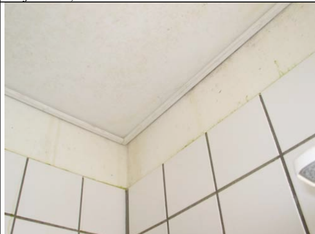
Afdeling L, stuen til højre Venstre baderum Højre for dør
