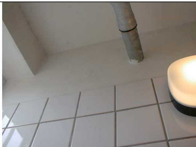
Afdeling K, stuen til venstre Venstre baderum Højre side, facade
