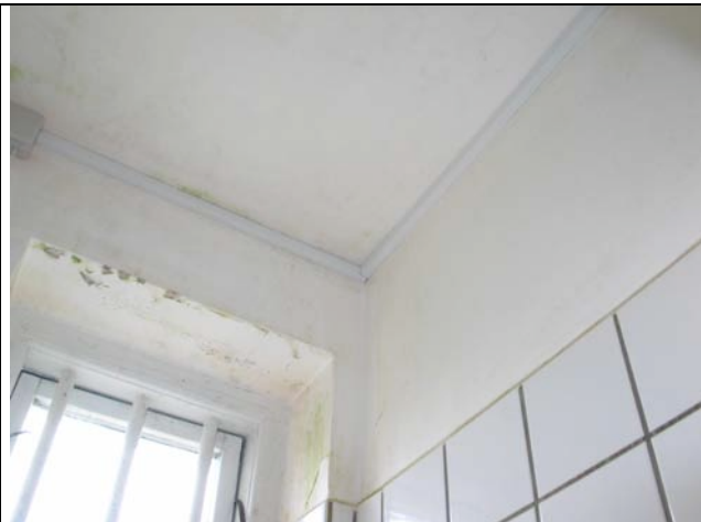
Afdeling M, 1. sal til højre Højre baderum Højre side, facade
