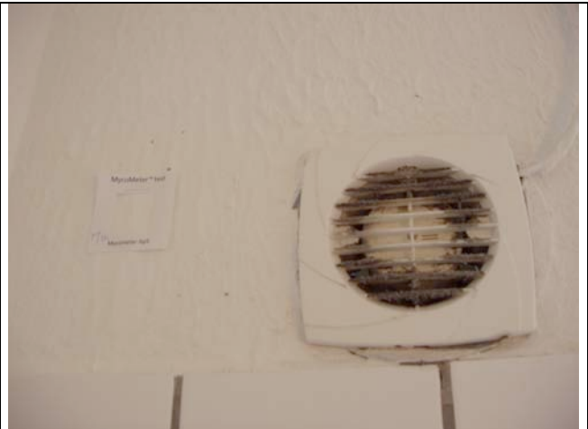
Afdeling M, Bad til højre Prøve ved ved ventilator
