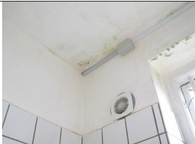
Afdeling M, 1. sal til højre Højre baderum Venstre side, facade
