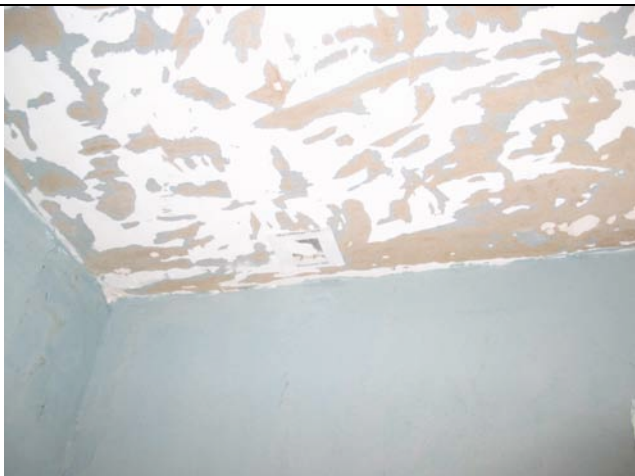
Kvalitetskontrol efter afrensning. MycoMeter
